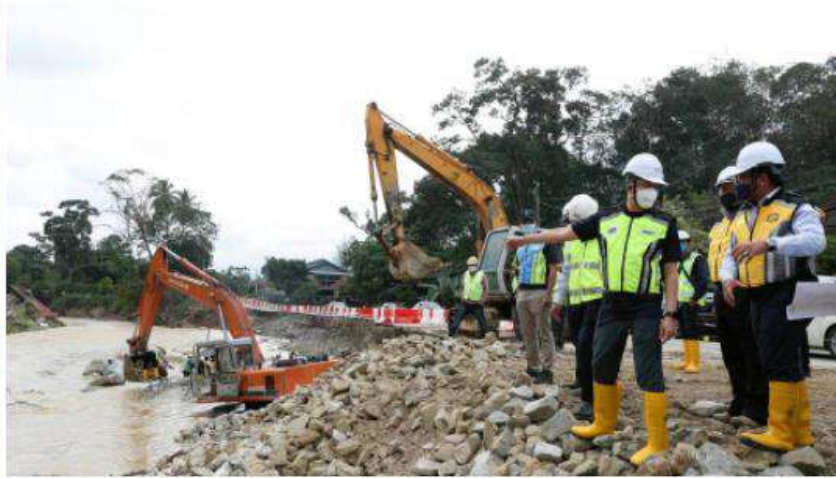
Fadillah ketika melakukan tinjauan pemasangan Jambatan Bailey di Batu 19, Jalan Sungai Lui, Hulu Langat. - Foto Facebook Menteri Kanan Kerja Raya, Datuk Seri Fadillah Yusuf
