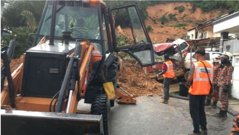
KEJADIAN tanah runtuh di Taman Bukit Permai.
